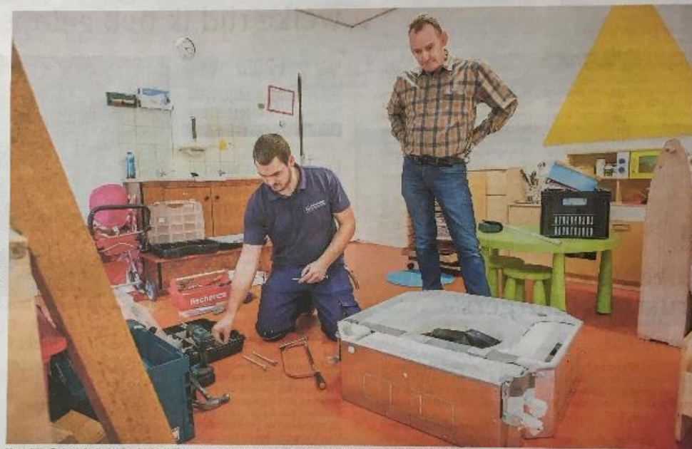
Voorzitter Robert de Jonge (rechts) bekijkt een van de warmtepompen die in het dorpshuis worden geïnstalleerd. — FOTO HUSMAN MEDIA
